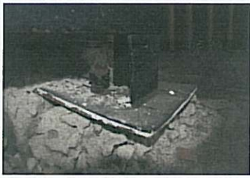
貯湯槽基礎の崩壊被害事例
