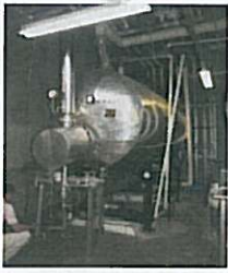
貯湯槽基礎の崩壊被害事例
